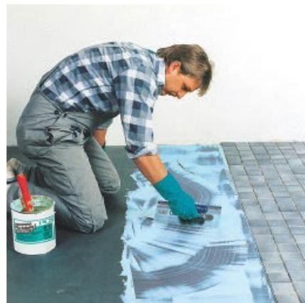
Клей PCI Collastic также можно наносить на стальные поверхности.
