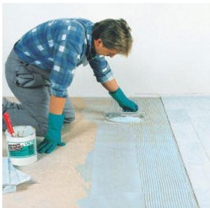
PCI Collastic можно наносить на чувствительные к влаге поверхности, такие как древесно-стружечные плиты.
