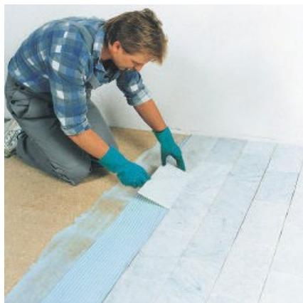
Плиточный клей на основе реакционной смолы PCI Collastic можно использовать для укладки мрамора на древесно-стружечные плиты.
