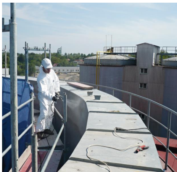
Нанесение состава MasterSeal M 336 с помощью безвоздушного окрасочного аппарата.
