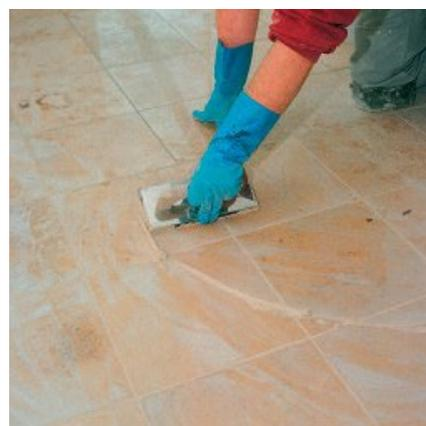
С помощью PCI Carrafug возможна надёжная укладка даже требующих особенно аккуратного обращения плит из натурального камня без их окрашивания.
