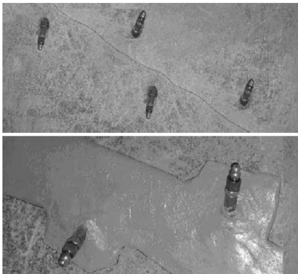
Рисунок 1. Пакеры, установленные вокруг трещины и герметизированные эпоксидным клеем MasterBrace или MasterFlow
